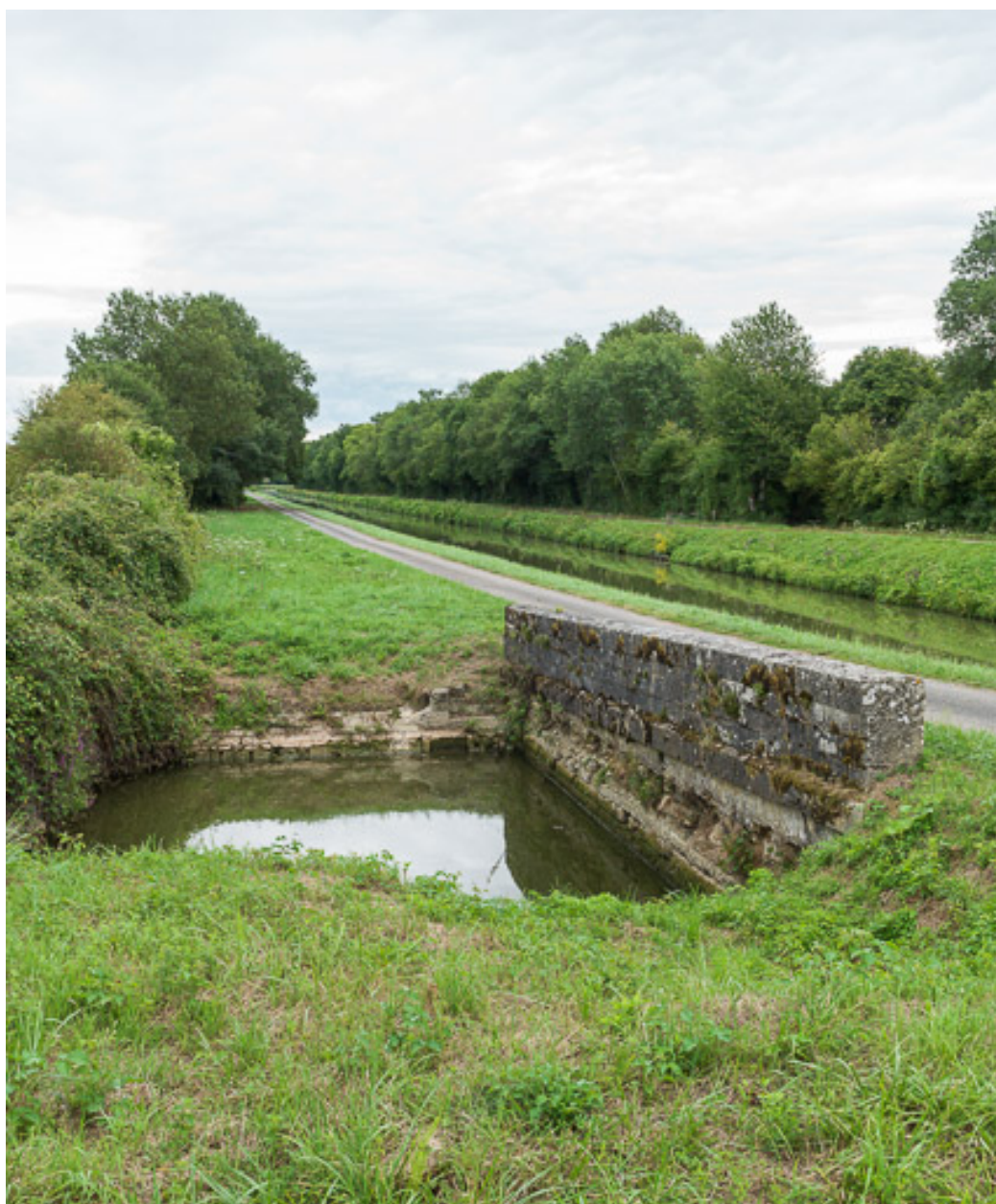
Vue de l'aqueduc.
