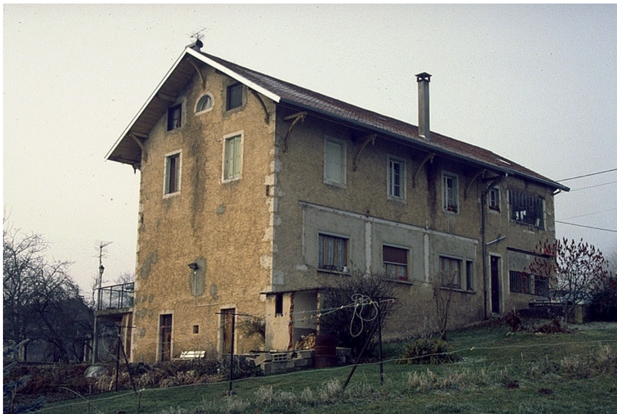
Façades postérieure et latérale gauche.
