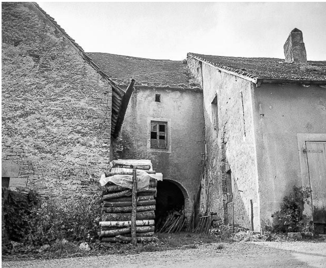
Détail de la façade postérieure.
