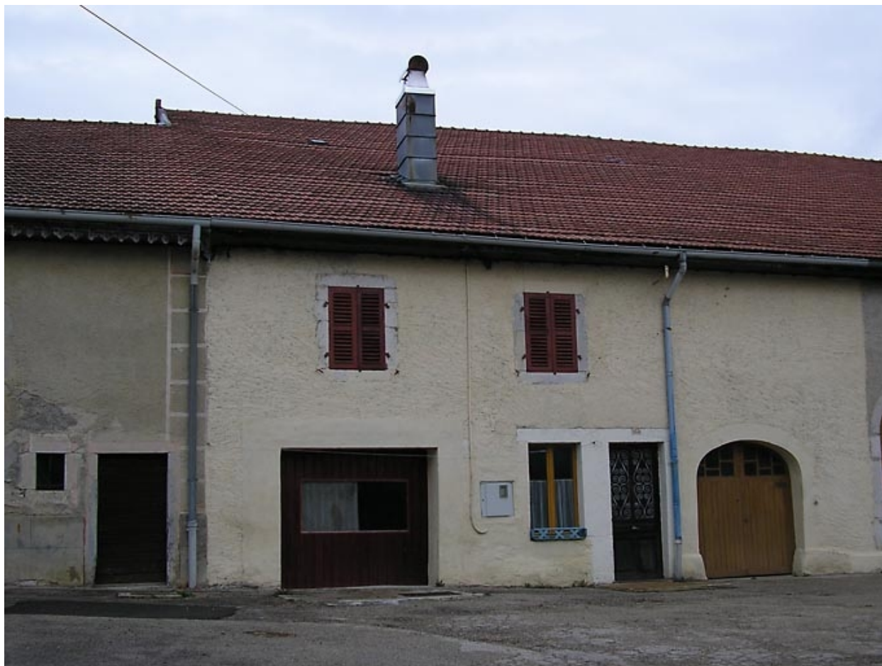
Vue latérale de la façade antérieure.
