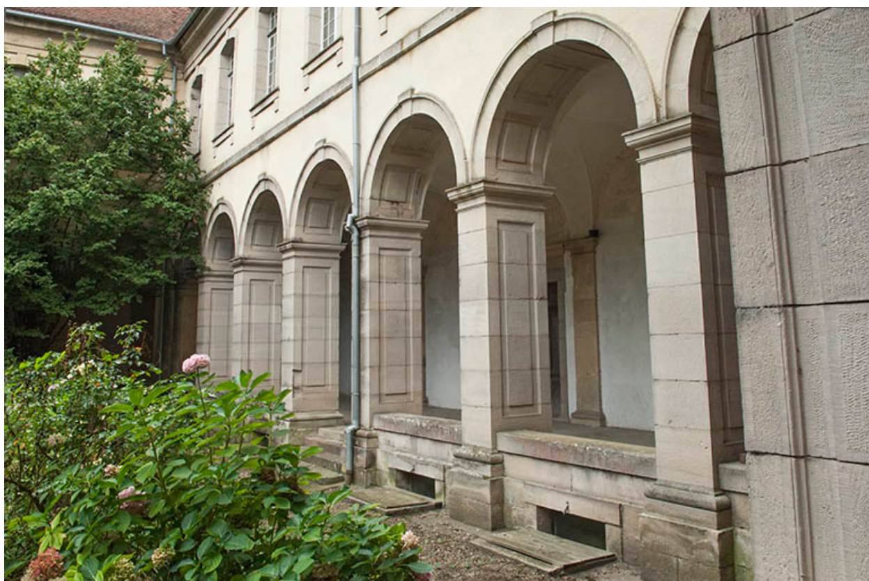
Vue rapprochée de la galerie est.
