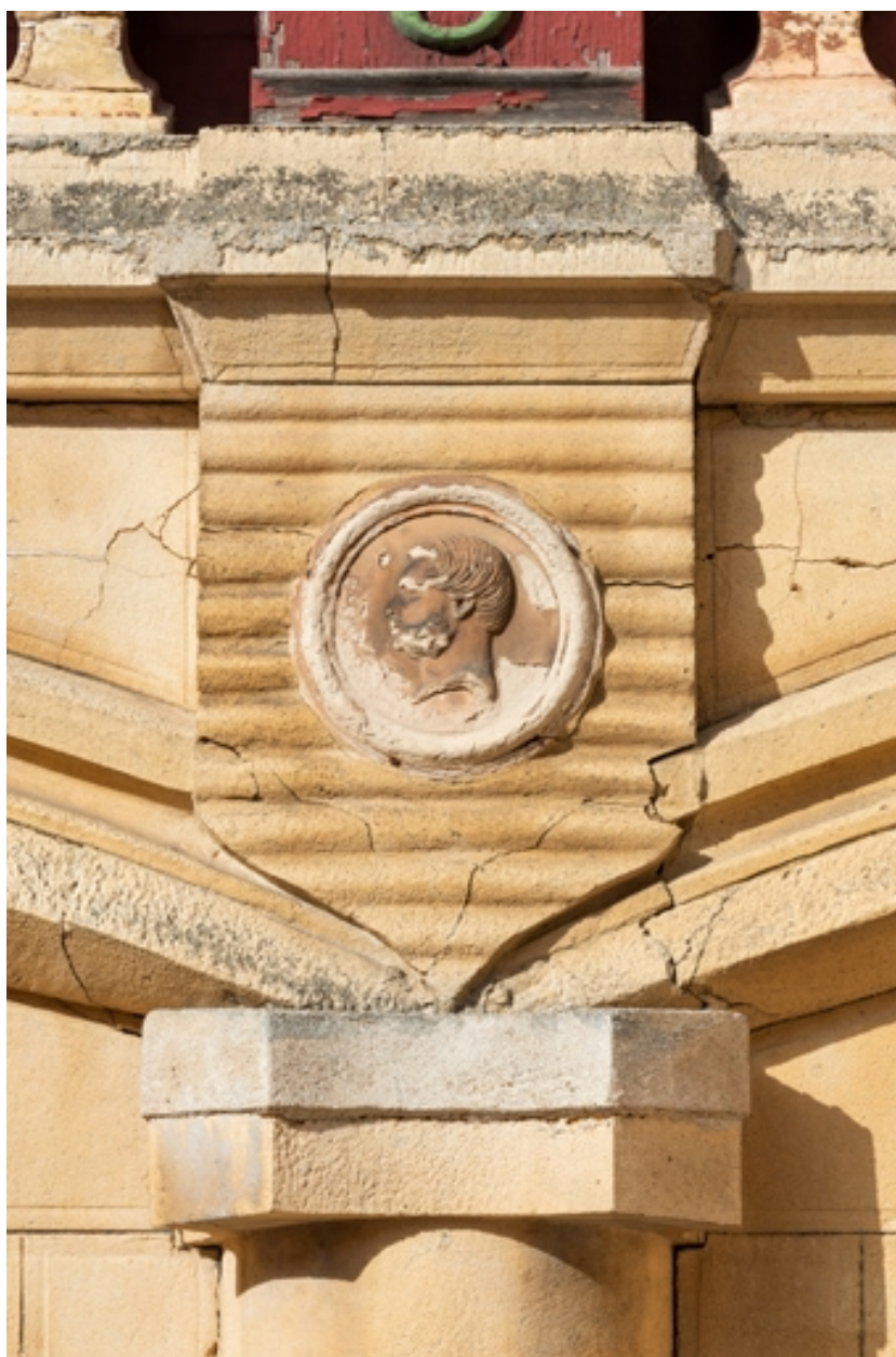
Bas-relief sur l'élévation antérieure de la maison.
