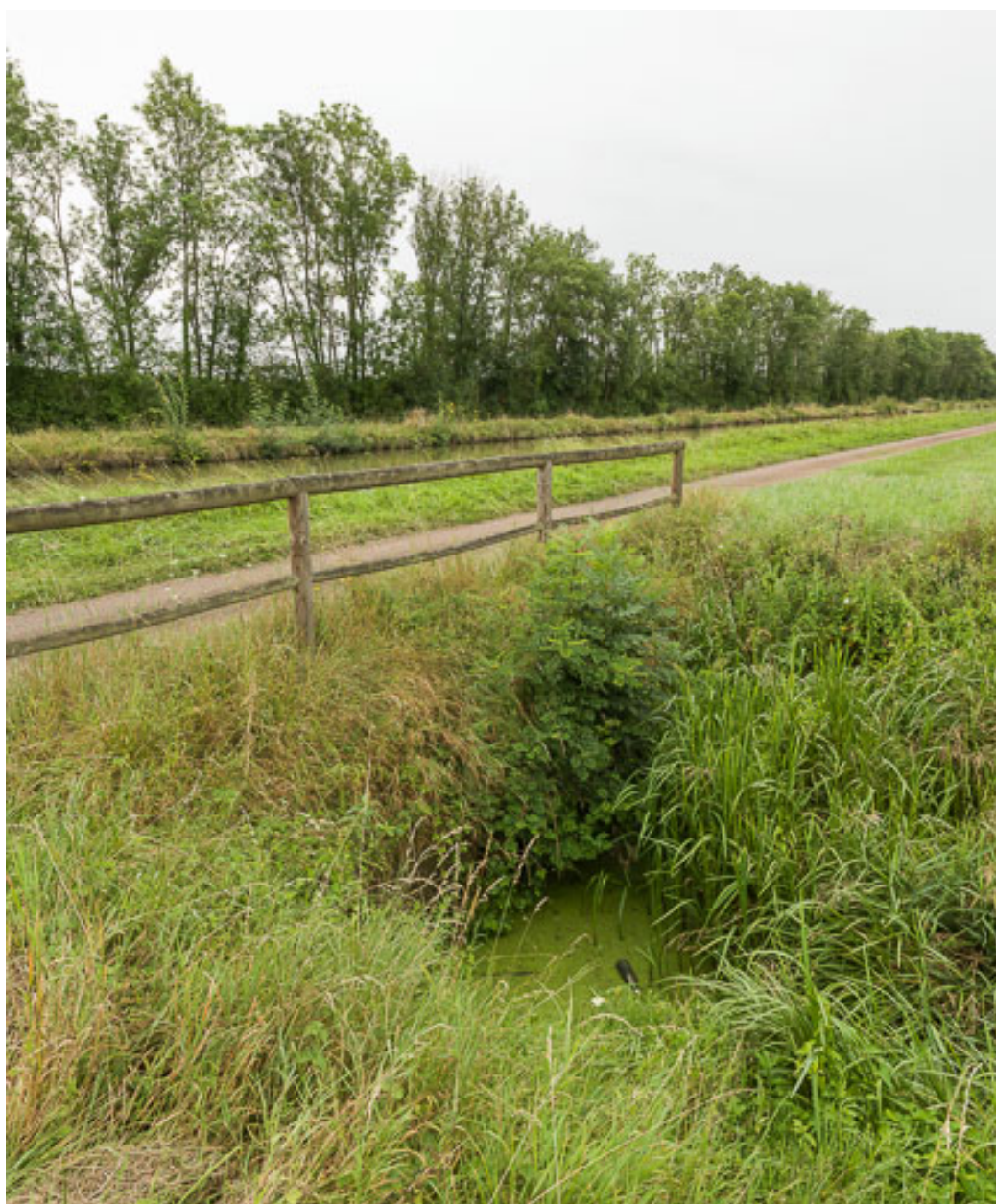
Vue de l'aqueduc.
