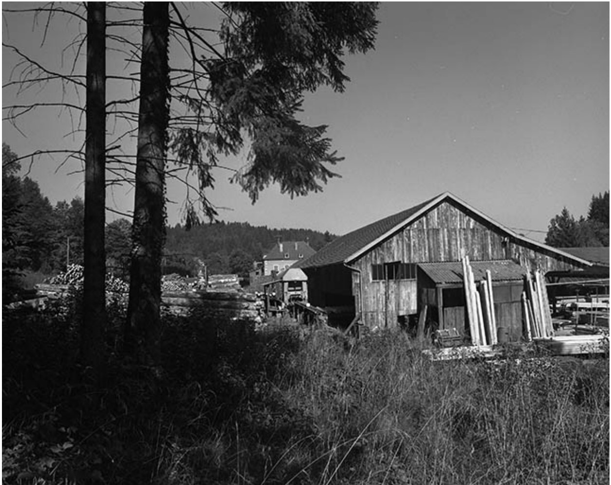
Atelier de fabrication (sciage) depuis le sud.
