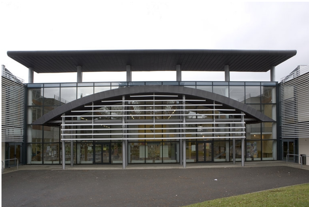
Vue façade antérieure bâtiment L.
