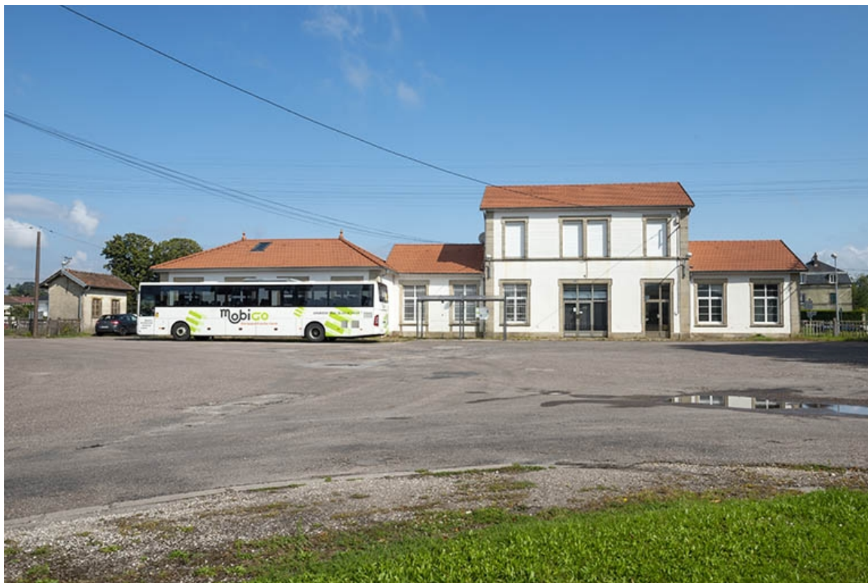
La gare, vue d'ensemble.
