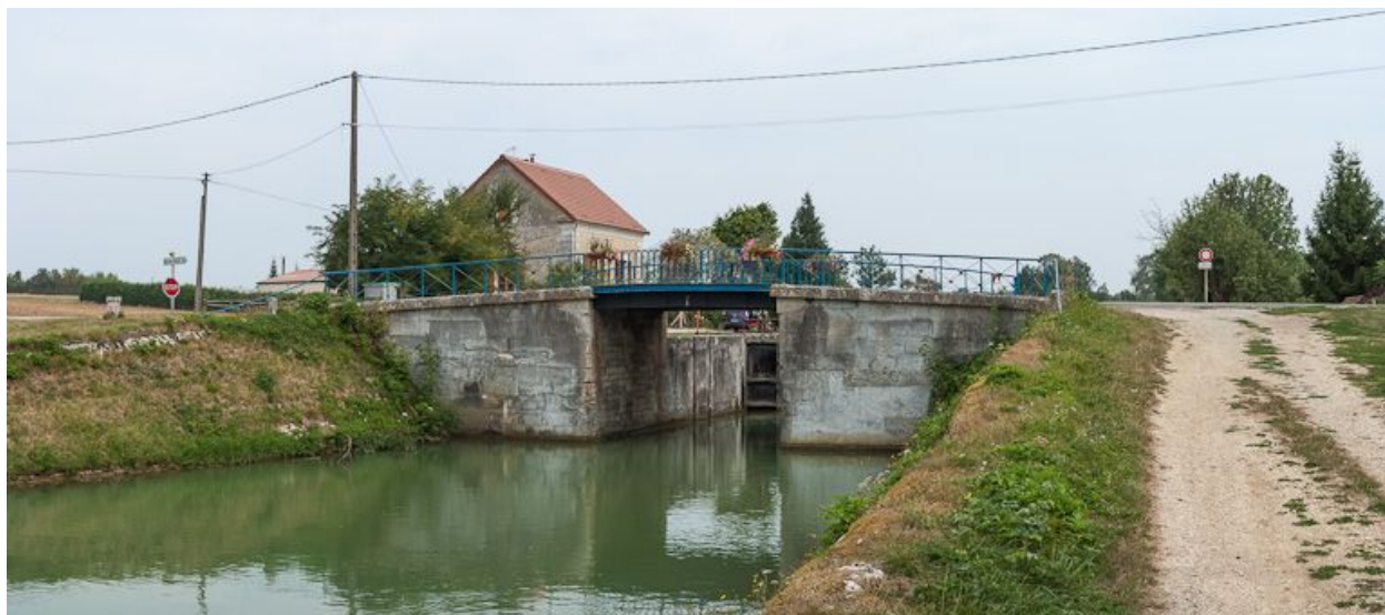
Le pont vu d'aval.
