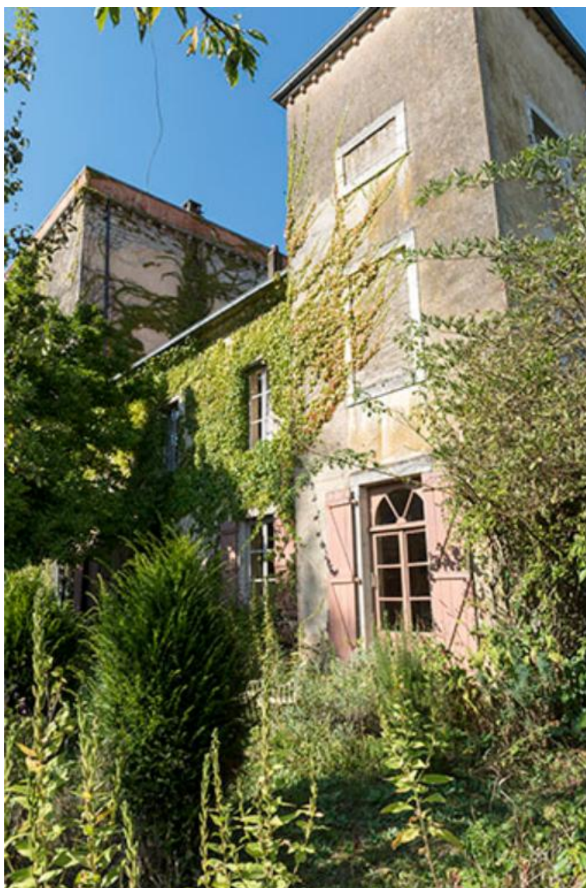
Aile du château côté Sud-Ouest
