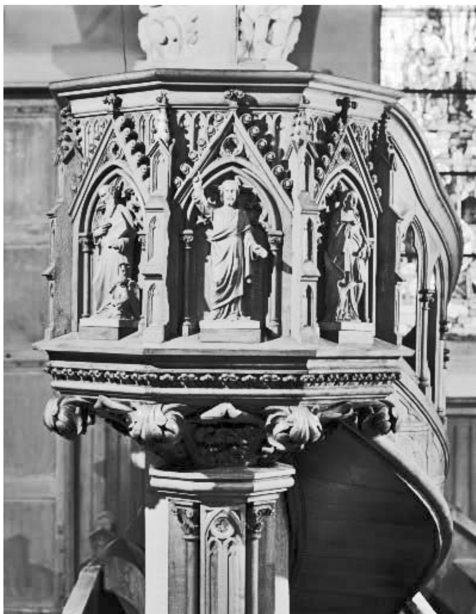
Détail de la cuve.
