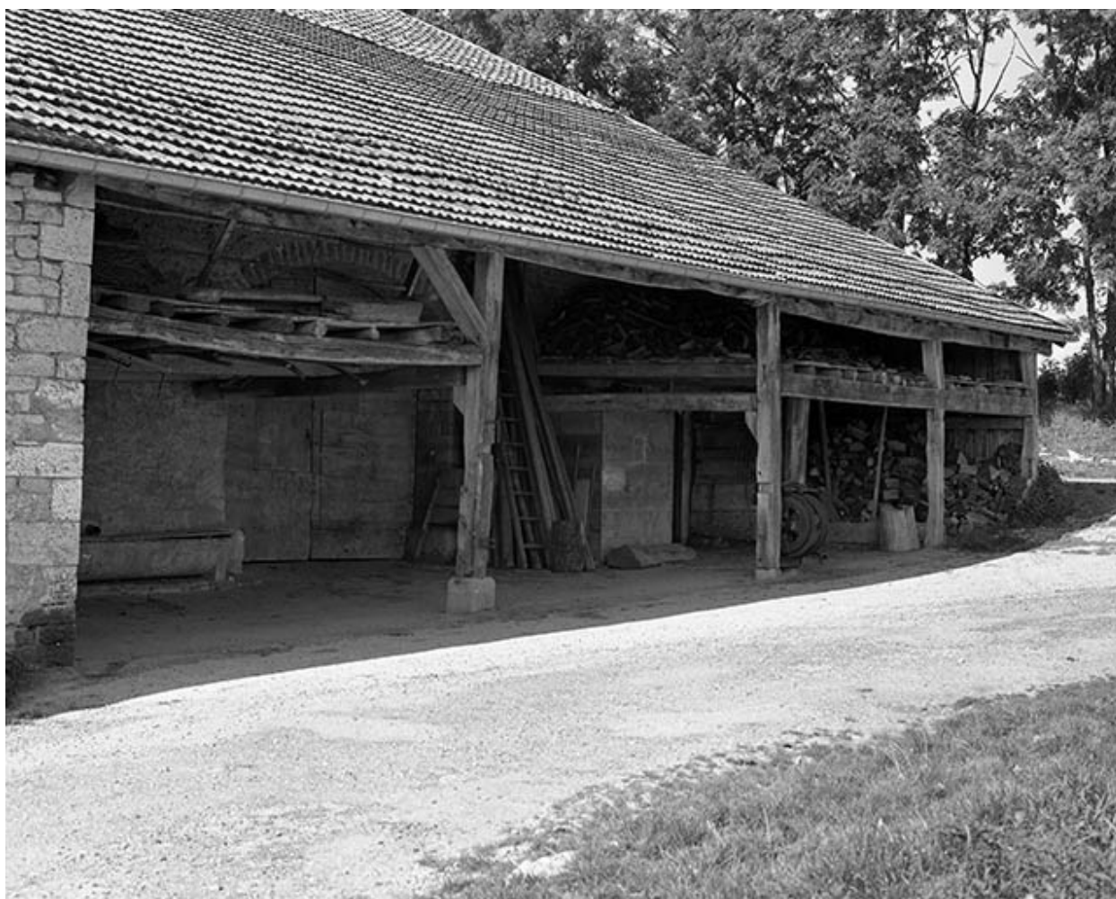
Façade latérale droite.
