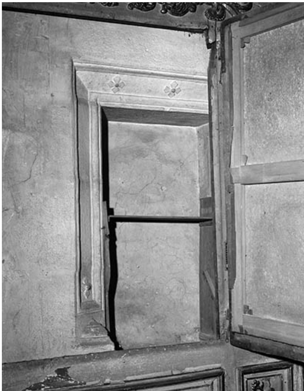
Intérieur, détail : niche du choeur.
