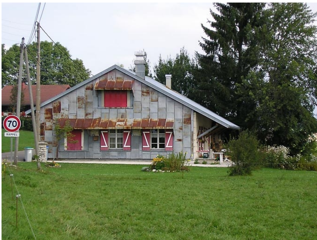
Vue de la façade sud-ouest.
