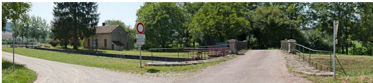
Vue d'ensemble du site d'écluse.
