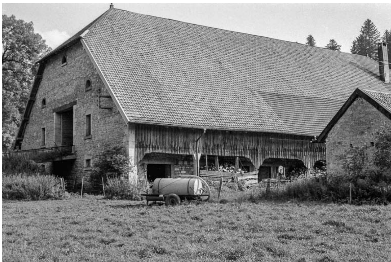
Façades postérieure et latérale gauche.
