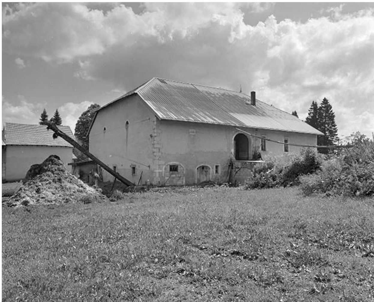
Façade postérieure et face droite.
