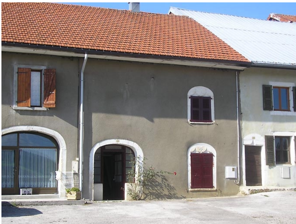
Vue de la façade antérieure.
