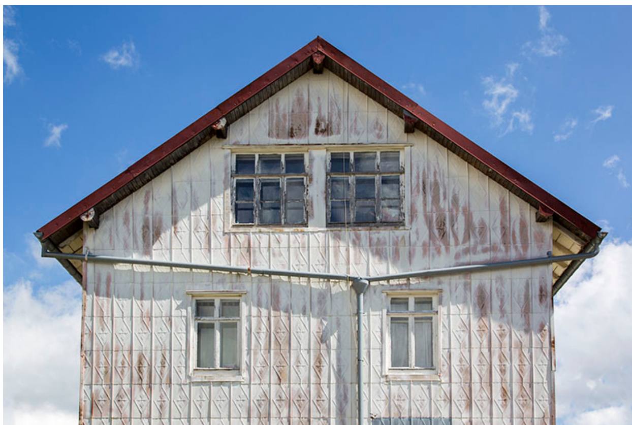
Façade latérale droite : fenêtres des niveaux supérieurs.
