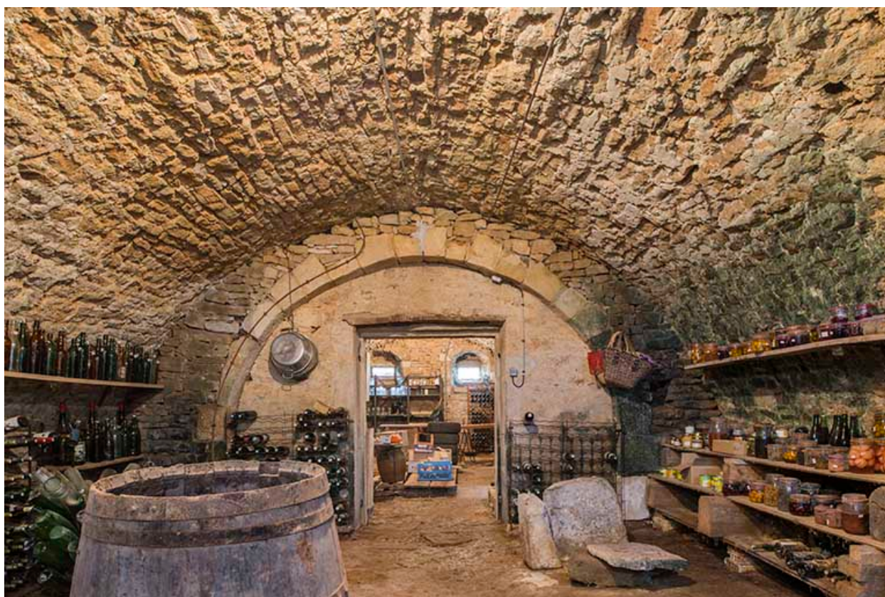
La cave voutée, vue générale.
