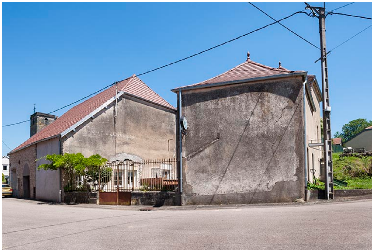
Vue depuis l'entrée de la mairie.
