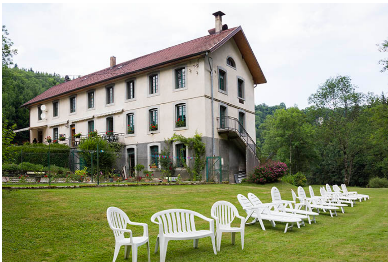
Moulin : façades antérieure et latérale droite.
