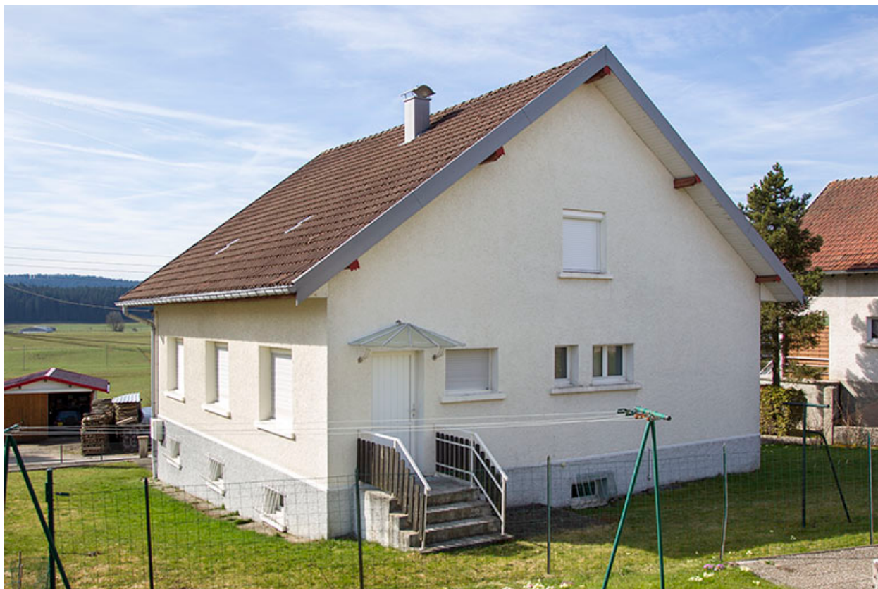
Façades postérieure et latérale droite.
