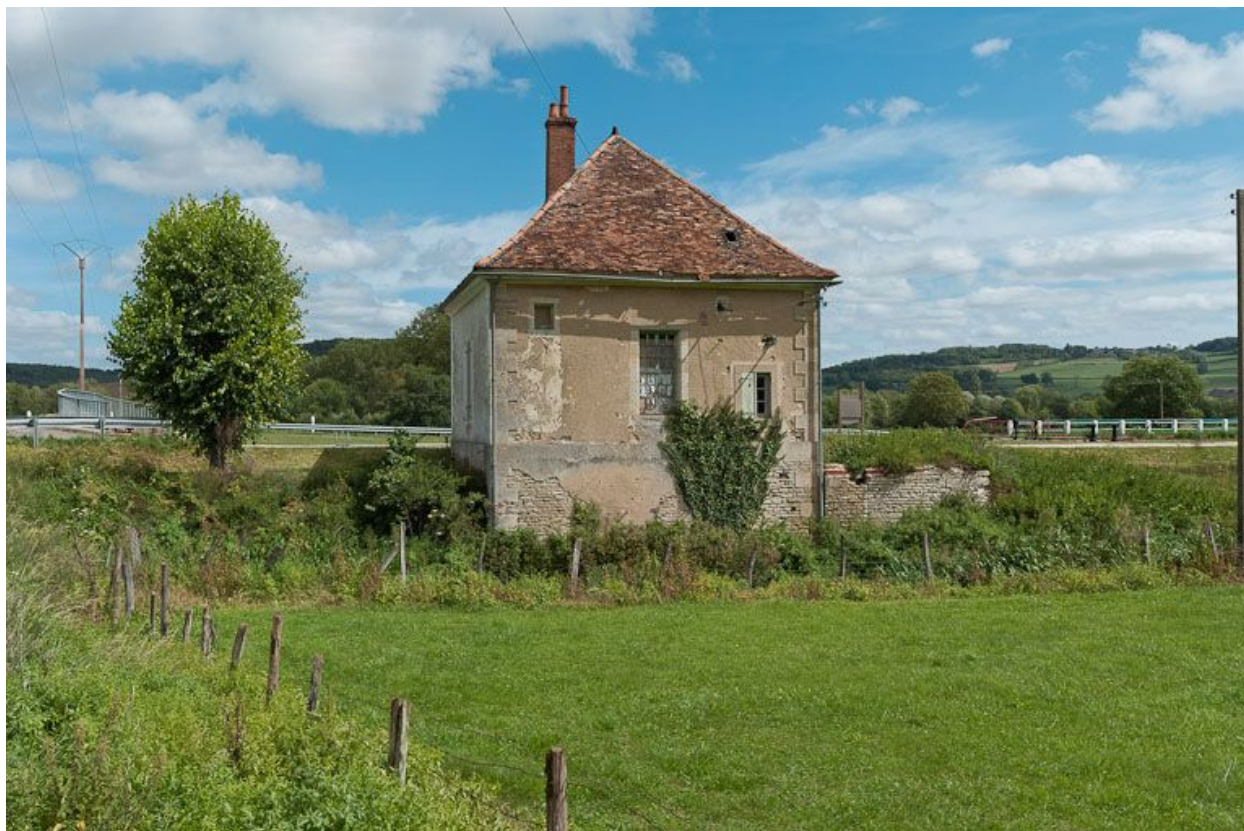
Vue de l'arrière de la maison éclusière.
