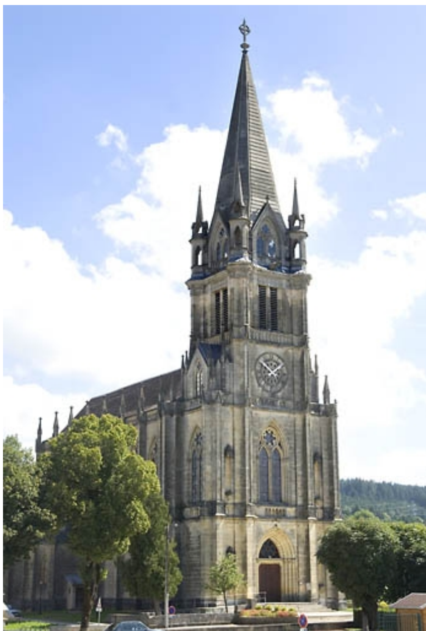
façade principale et clocher
