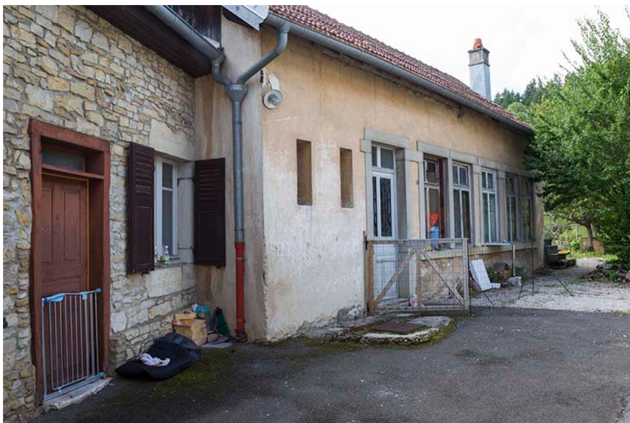
Usine : façade antérieure, de trois quarts gauche.
