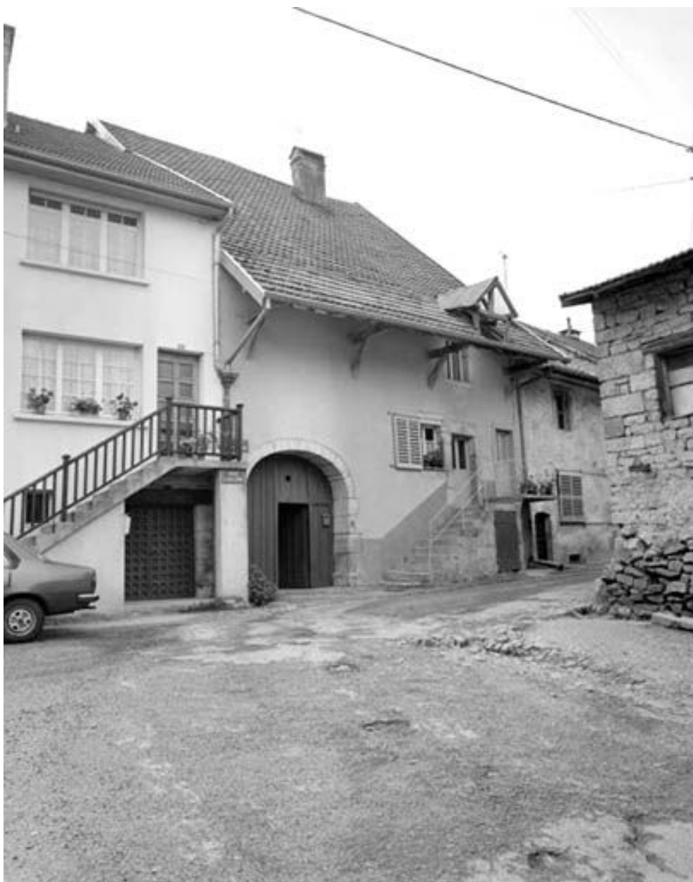
Maison située 16 rue du pont de Nahin.
