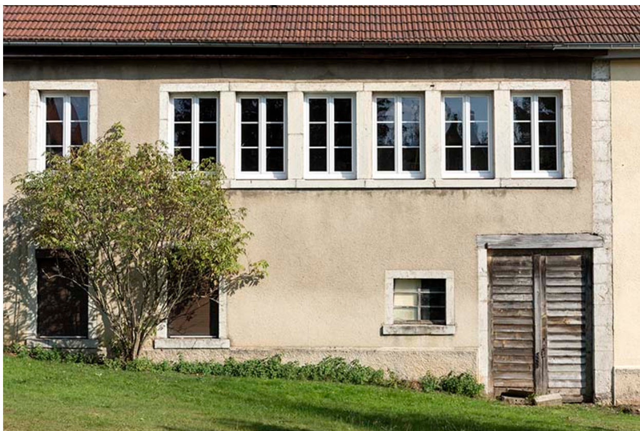
Façade postérieure : fenêtres multiples.
