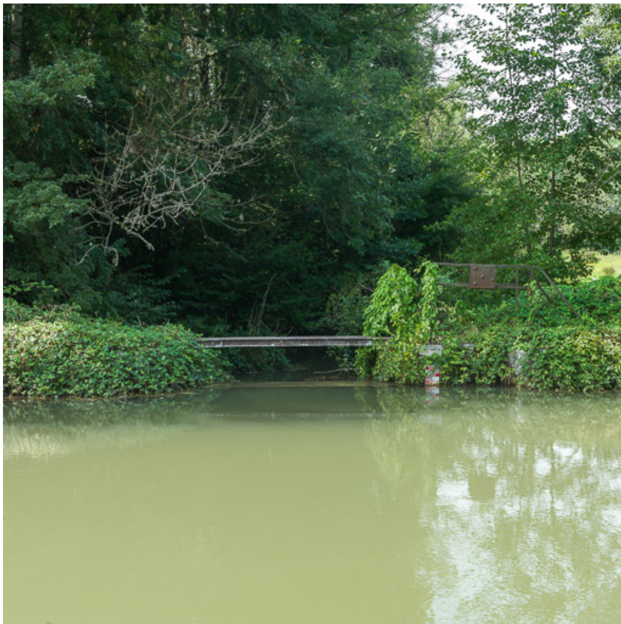
Vue du déversoir.
