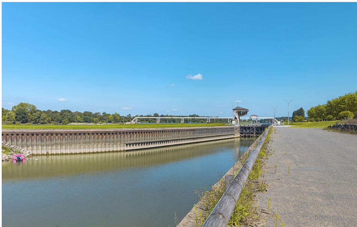
Murs-guides à l'aval du site d'écluse.
