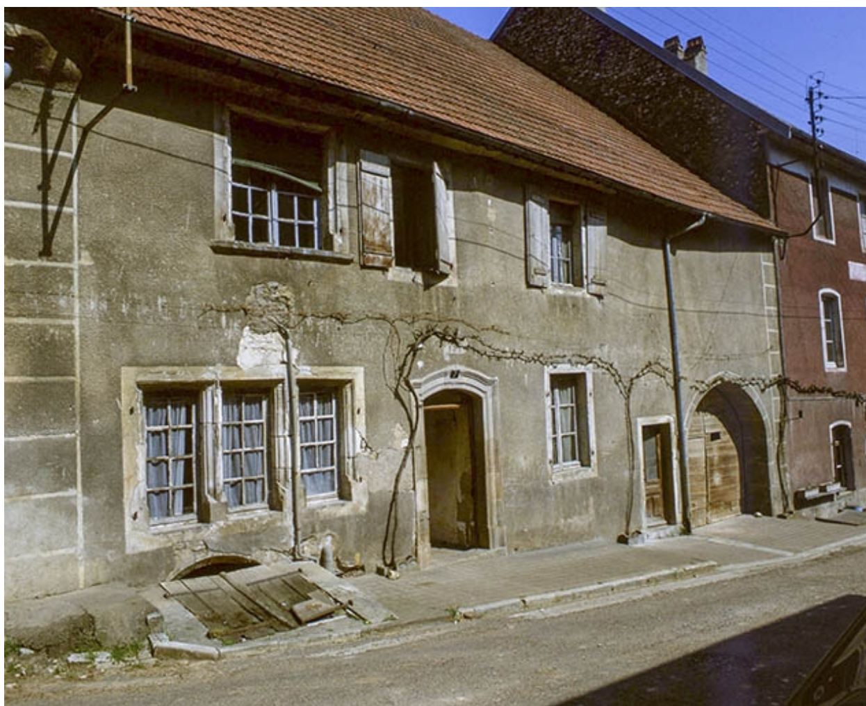
Ferme située rue Gambetta.
