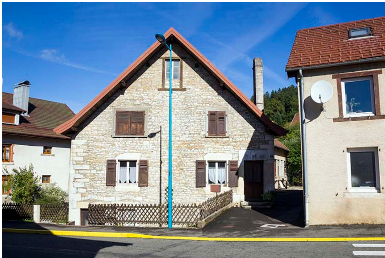
Maison : façade antérieure.
