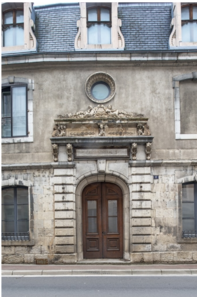
Façade est, portail d'entrée.
