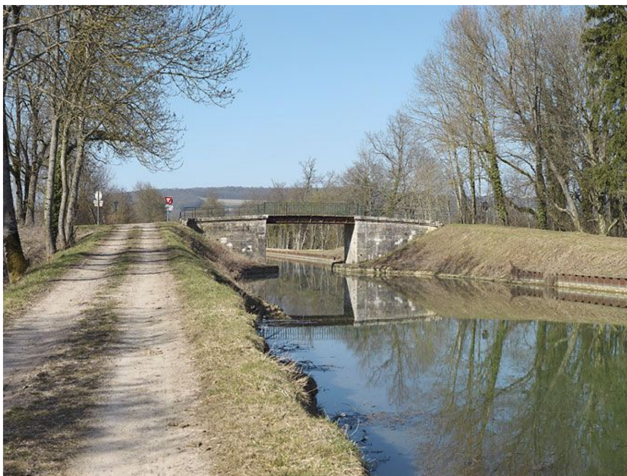
Le pont vu d'amont.
