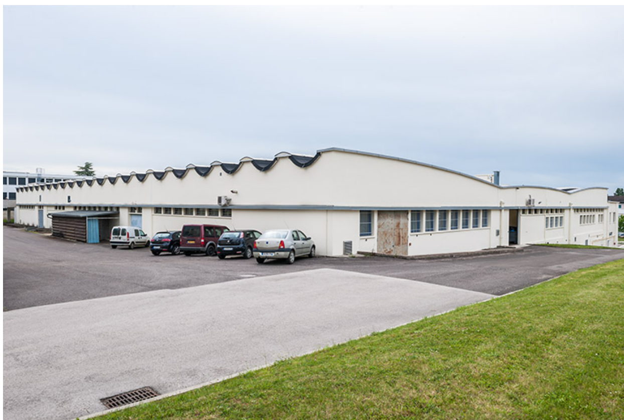
Ateliers : vue générale des façades arrière.
