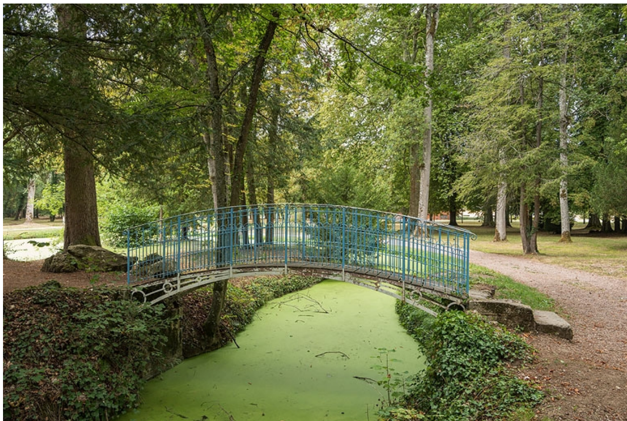
Passerelle métallique donnant accès à l'île.
