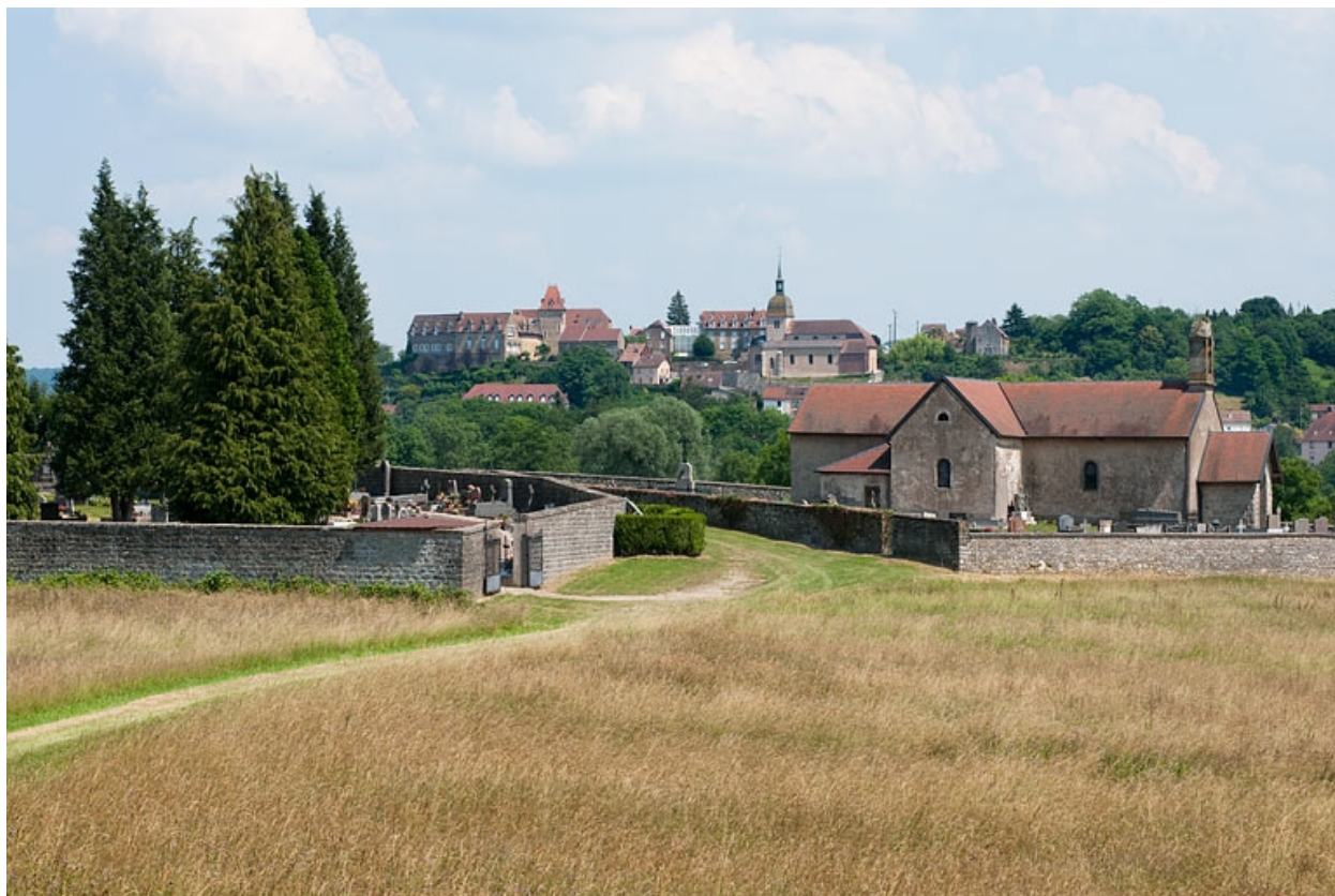
Vue générale, avec Rougemont en arrière-plan.
