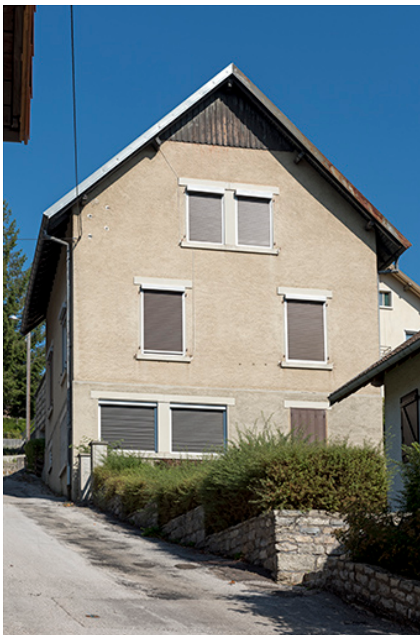
Façade latérale droite.
