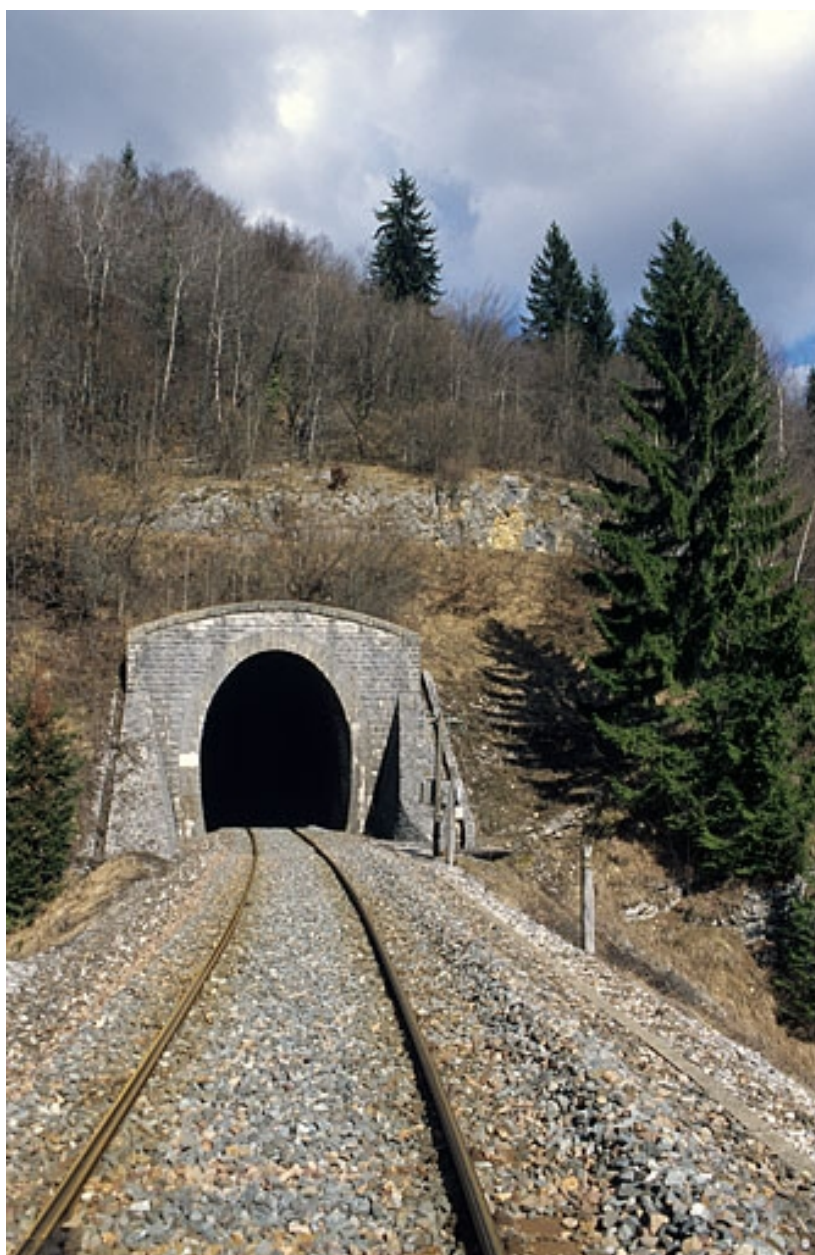
Tunnel : tête côté La Cluse (ouest).
