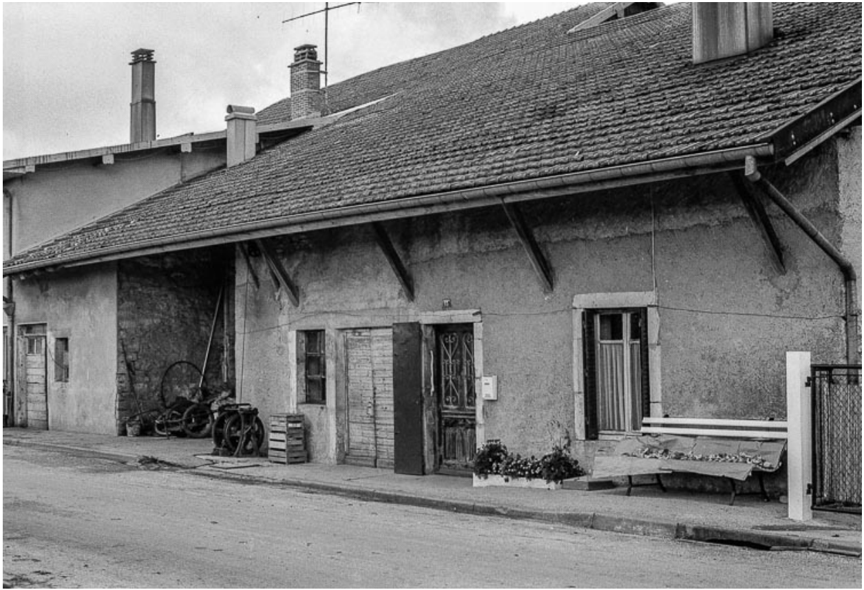
Ferme située 13 rue du Moutet : façade antérieure.
