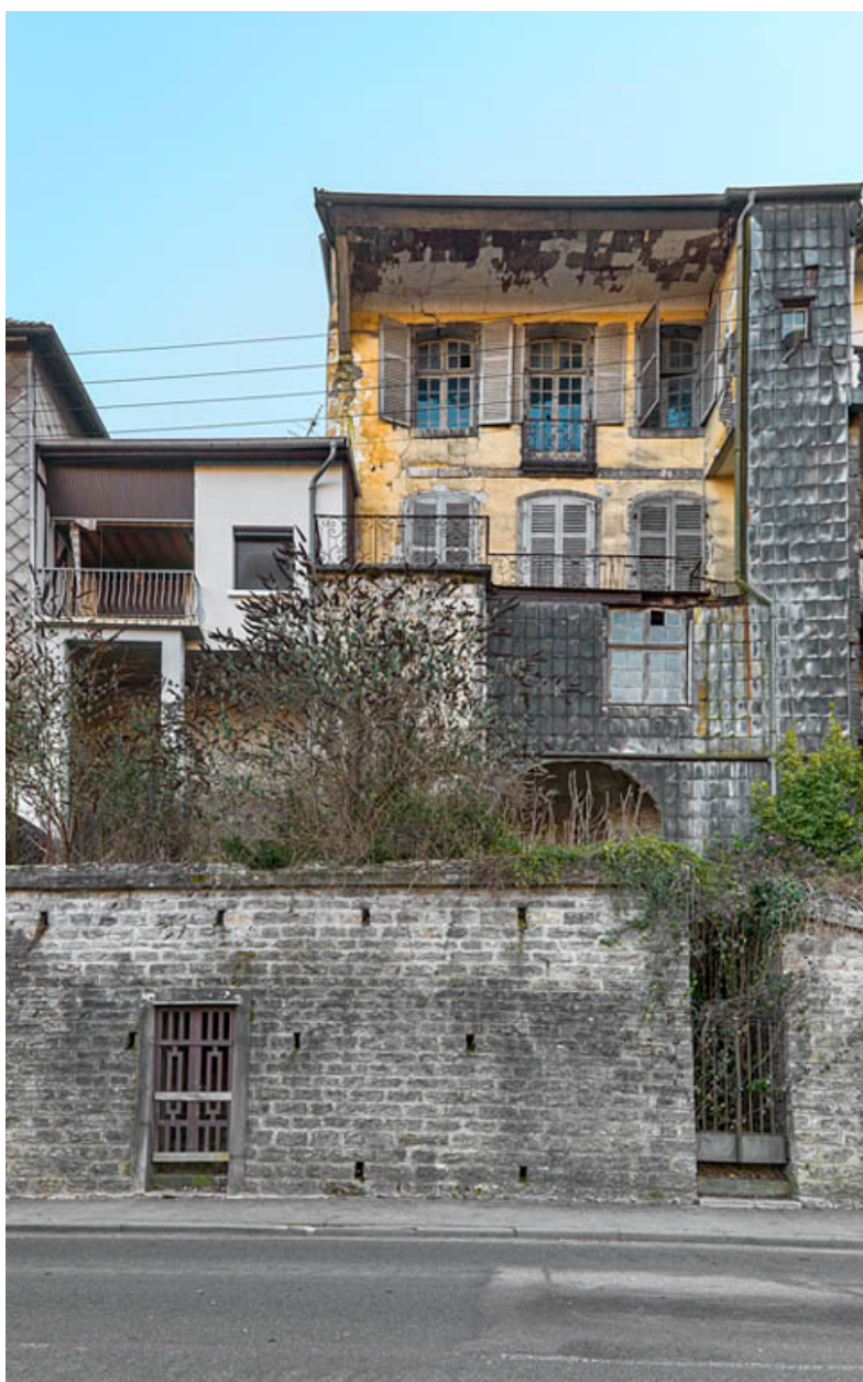
Vue en contre-plongée, depuis l'ouest.
