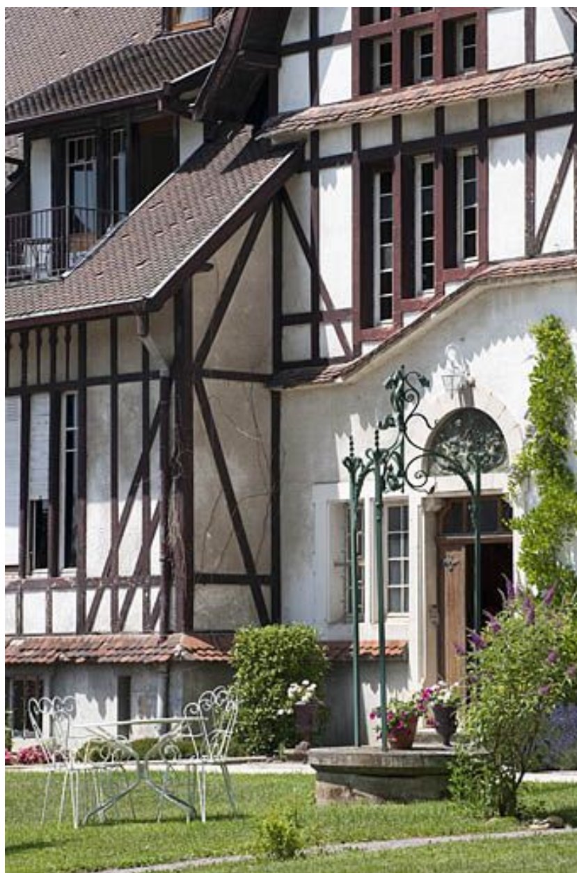
Façade sud vue de trois quarts.
