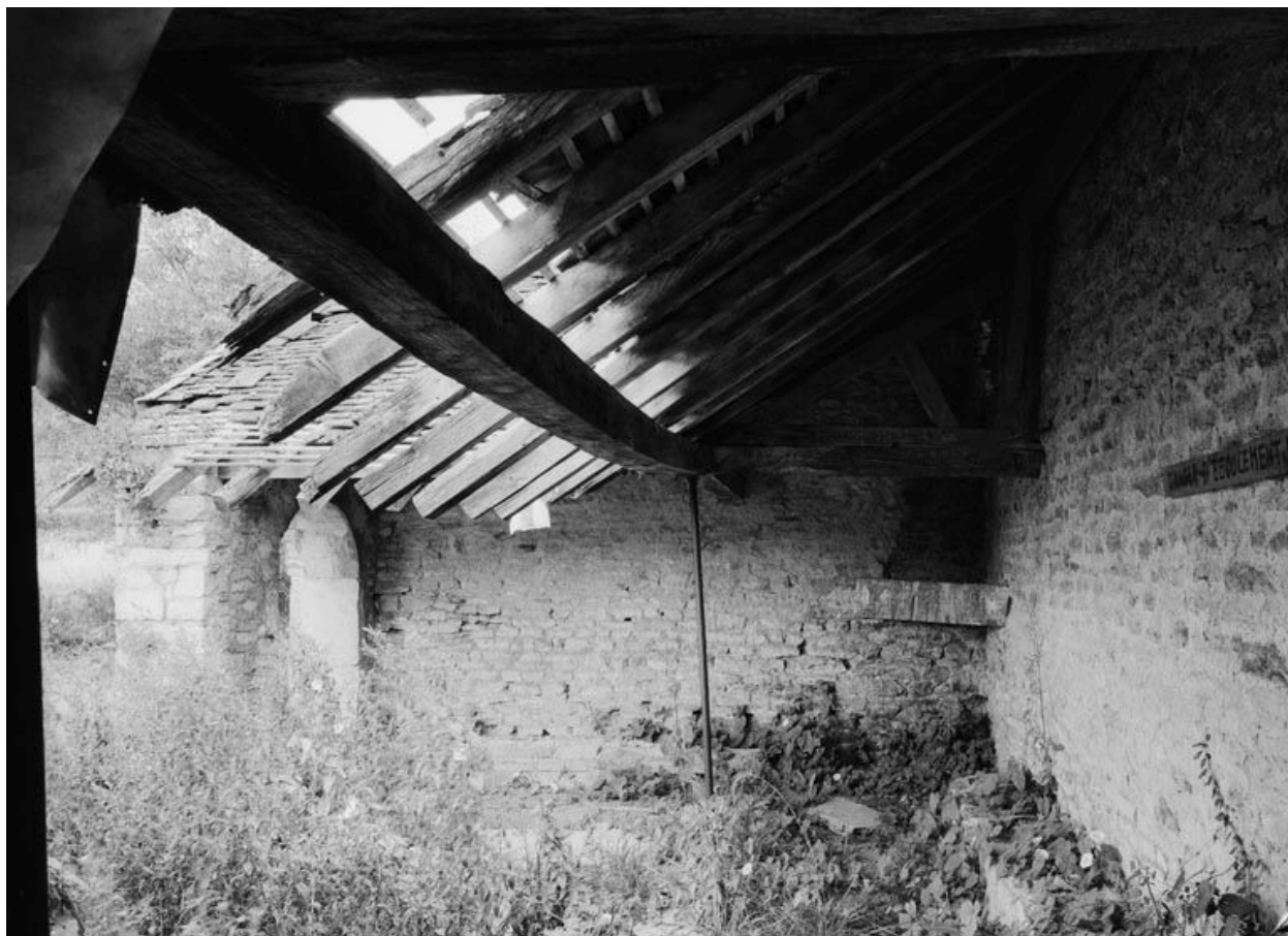
Vue de l'intérieur du lavoir.
