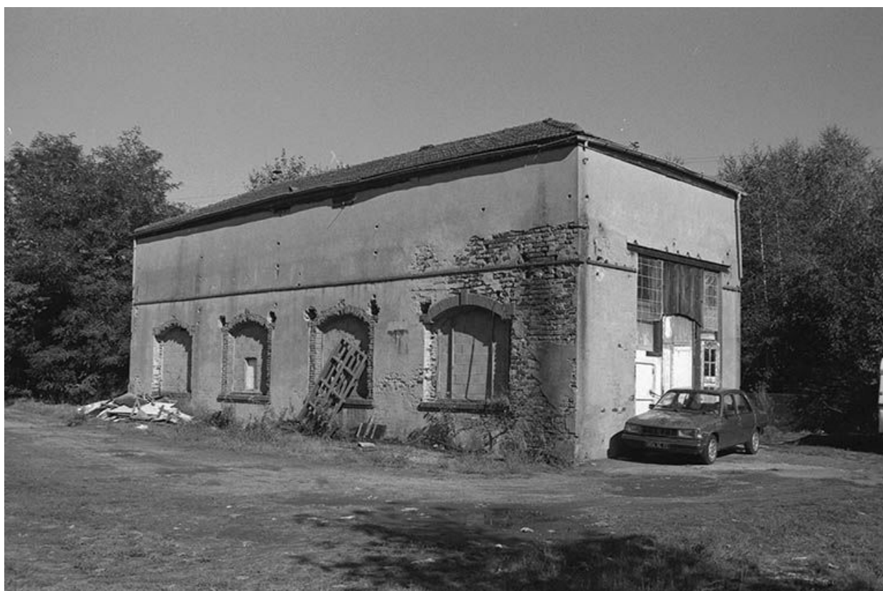
Salle des machines, vue du sud-ouest.
