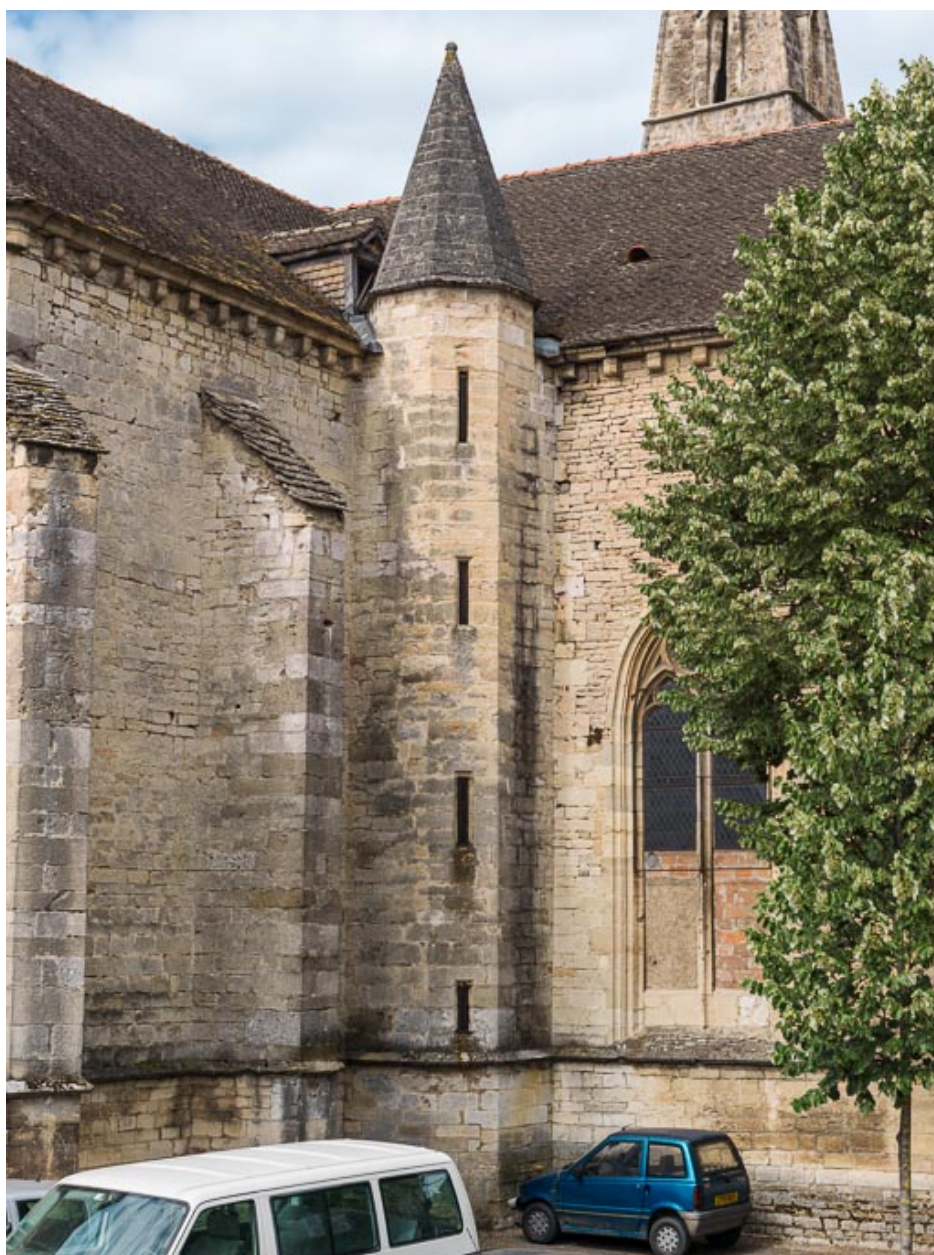
Vue de la tourelle d'escalier.
