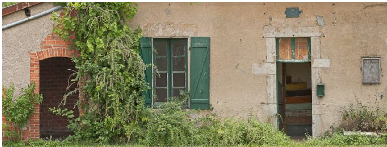
Détail des baies de la maison éclusière.
