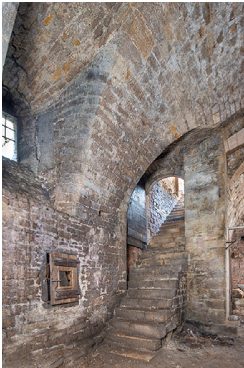
Escalier d'accès à la cave.
