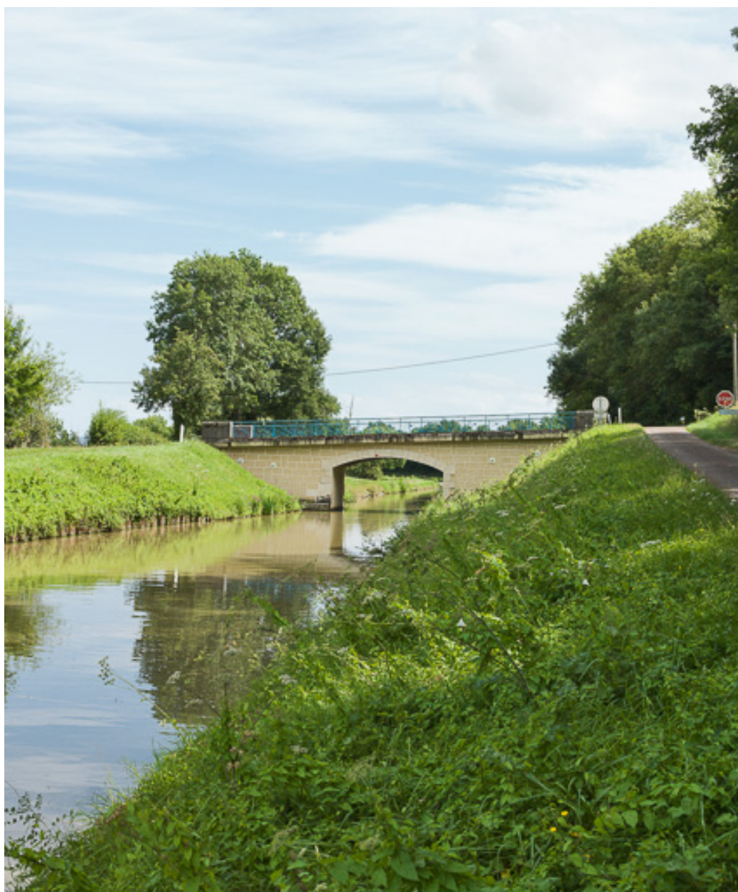
Vue d'ensemble du pont et du site.
